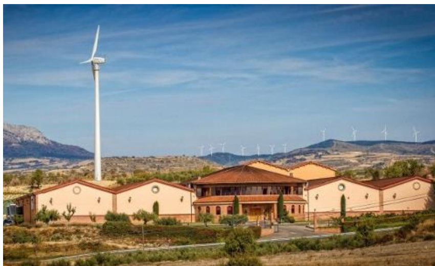
Figura 3. Aerogenerador de Argolabe [16]
