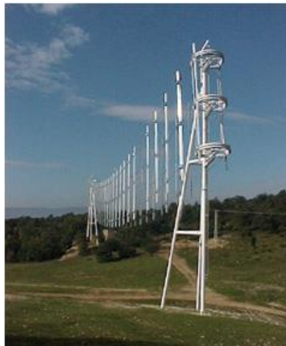
Figura 2. Aerogenerador de traslación instalado en Burgos [13]
