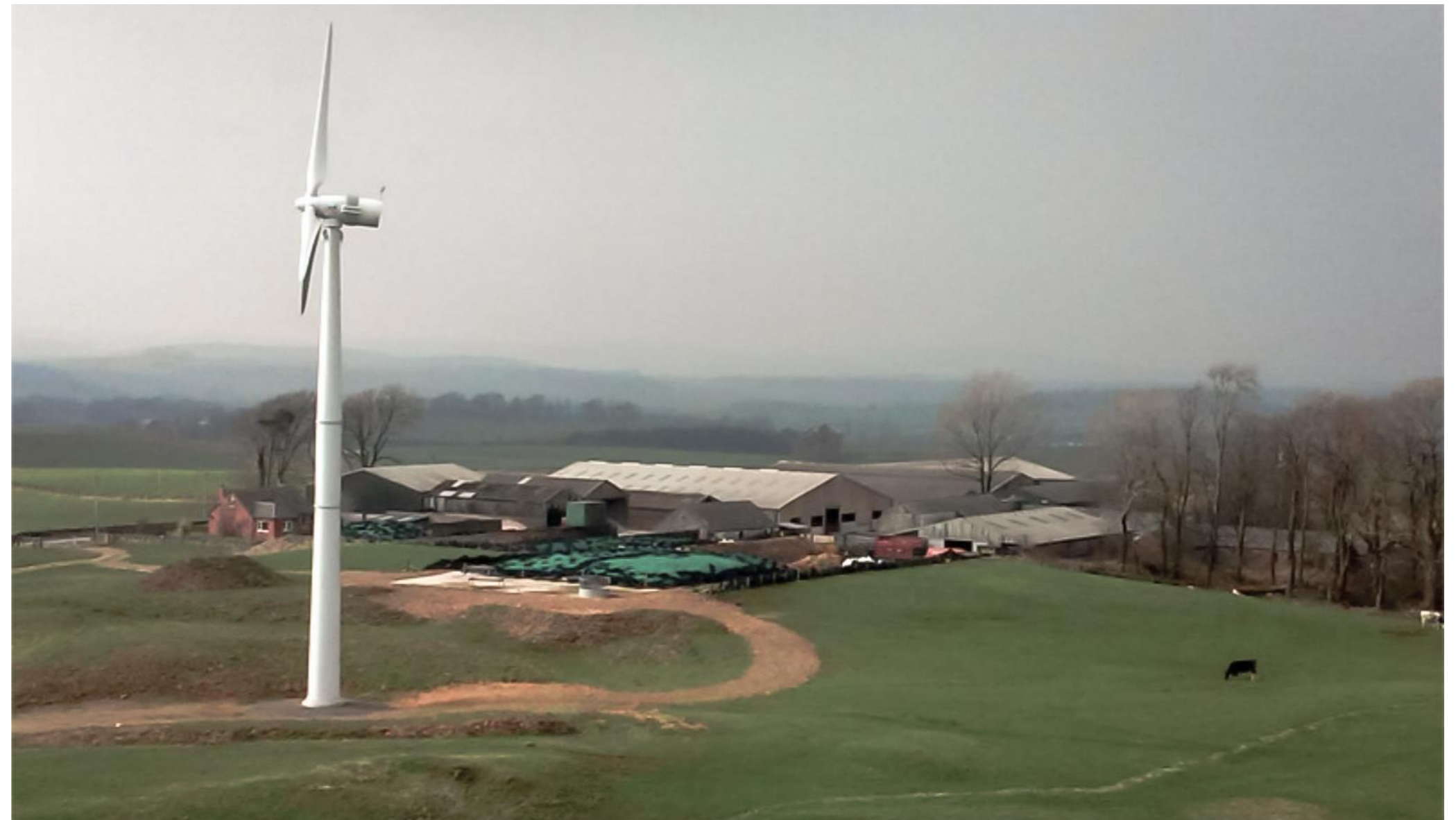
Aerogenerador nED100 instalado en una explotación agropecuaria - Reino Unido
