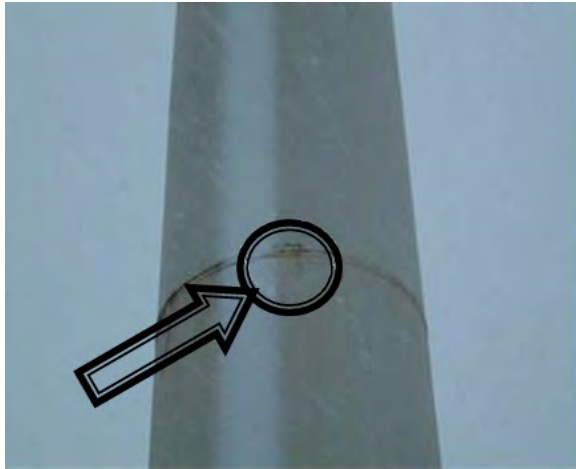
Grieta en la soldadura de la torre
